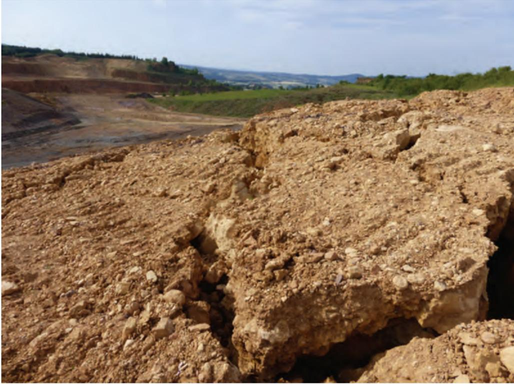
**Photo n° 2** - *Les fissures dans la masse du glissement.*
